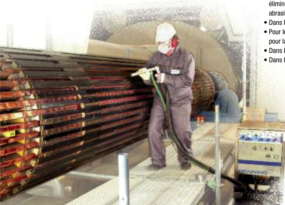
Nettoyage à sec d'un inducteur sur site
