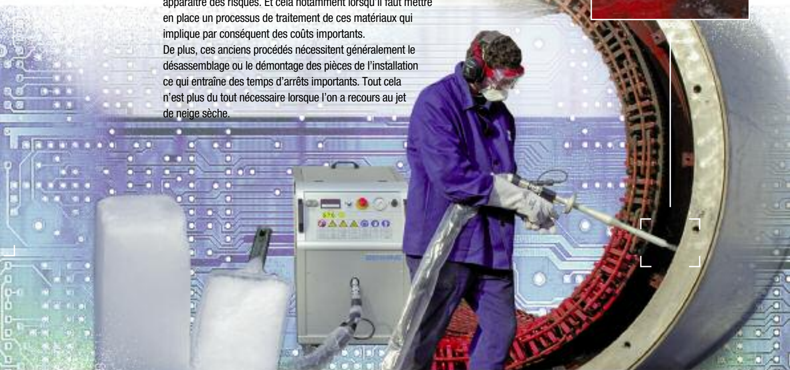
La photo montre bien la différence avant et après nettoyage
