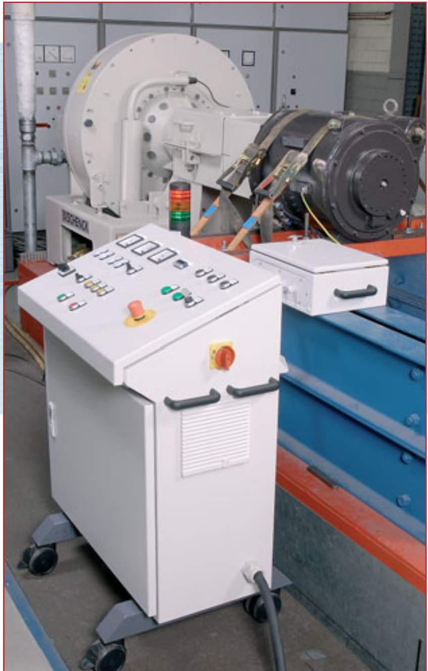
► Mobiler Prüfstand AC, Anschlusskasten und gebremster Fahrtrieb
